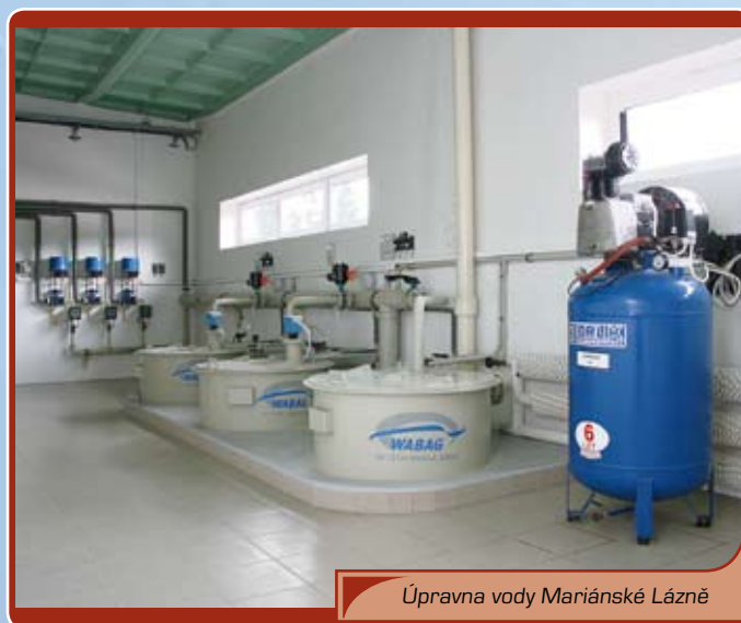
Úpravna vody Mariánské Lázně
