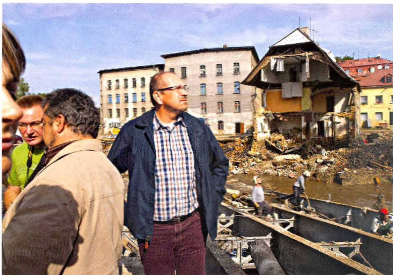
ZDEMOLOVANÁ CHRÁSTAVA. Ministr zemědělní Ivan Fuksa v místě, kde voda strhla socešní most.
